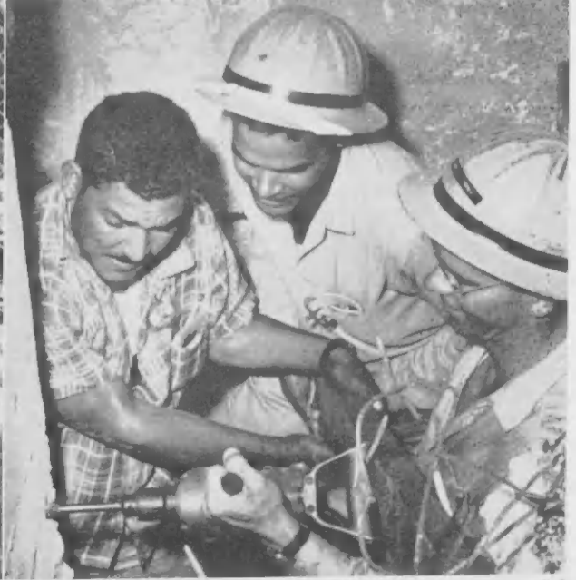
UN SISTEMA di grounding ta instalá door di trahadornan, ariba robéz. Otronan ta parehá e concreto bashá promer cu e sanja ta yená, ta soldear e cablenan cu ta bai pa e sistema di grounding di e substacion di gobierno, y ta traha encaje door di cual Lago su cable di corriente lo worde conectá na e equipo di switch di gobierno.
